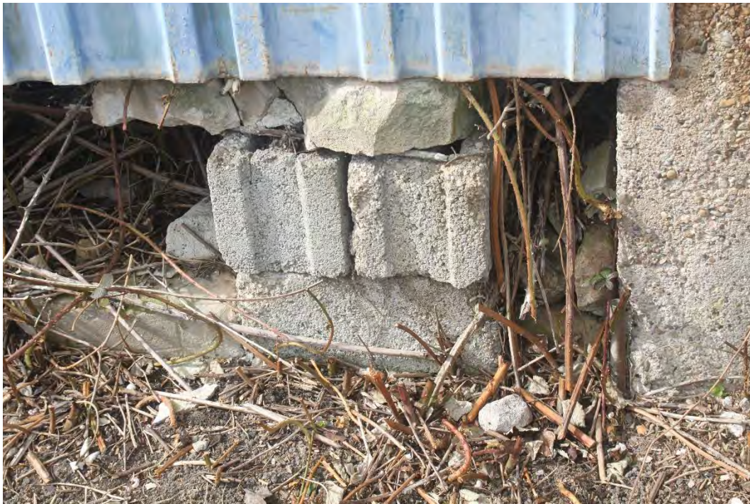
Abb. 2: Fugenreiche Mauer aus Beton – potentielle Versteckmöglichkeit für Mauereidechsen
